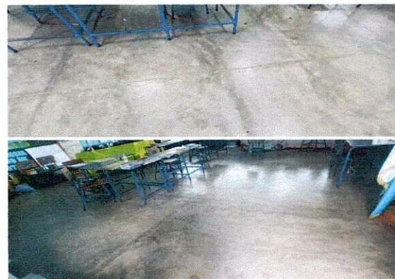
**Foto 4:** El piso se encuentra agrietado por el paso de los años de la construcción del edificio.
